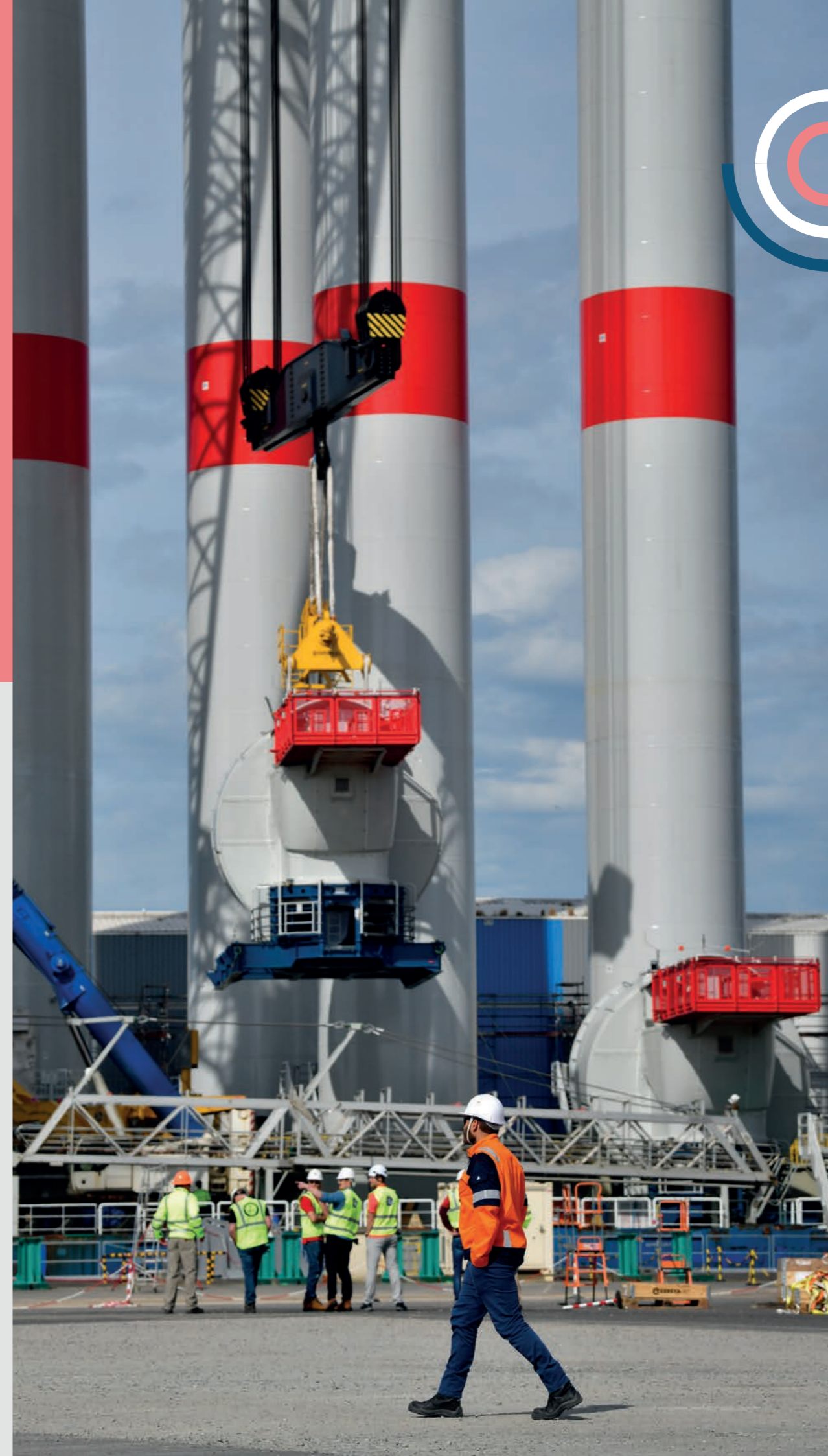
Pré-assemblage des éoliennes posées du parc éolien en mer de Saint-Nazaire.
