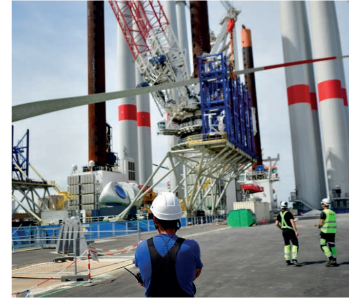
Techniciens du parc éolien en mer de Saint-Nazaire.
