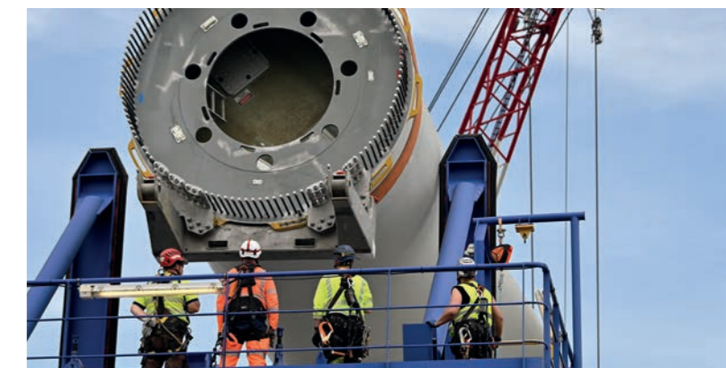
Techniciens du parc éolien en mer de Saint-Nazaire.
