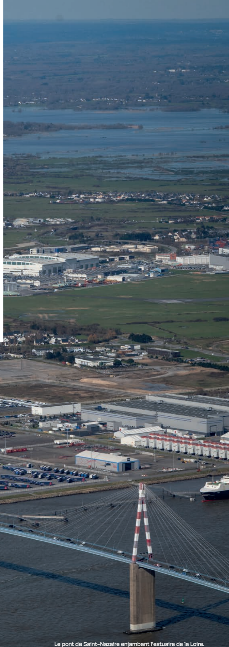
Le pont de Saint-Nazaire enjambant l'estuaire de la Loire.
